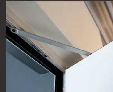
**Im Türflügel verdeckter Obertürschließer mit Riegel**
